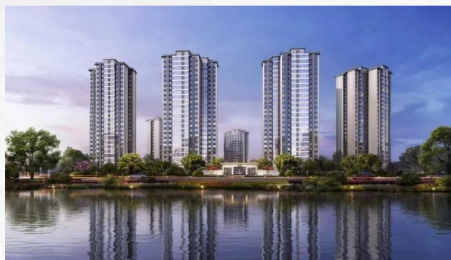
遂宁-邦泰-时代之城项目
