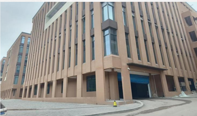
重庆—建桥 C 区生物医药园项目
